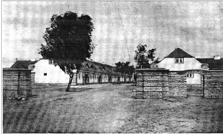
Haupteingang in die Siedlung von der Stadt aus Von der Eingangsmauer nach den Giebeln ist eine 2 m hohe Lindenhecke als Abschluss gepflanzt
